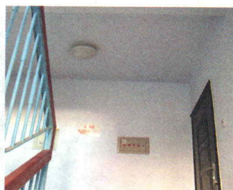
图 9-4-2 住宅楼道灯的右下方所装开关为声光控延时开关
