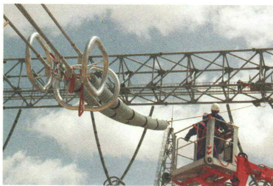
图3 特高压线路铺设
