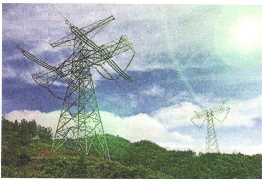
图4 特高压输电线
