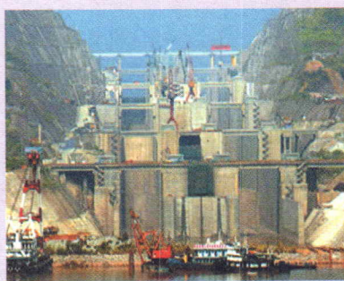
图 9-3-6 雄伟的三峡船闸
