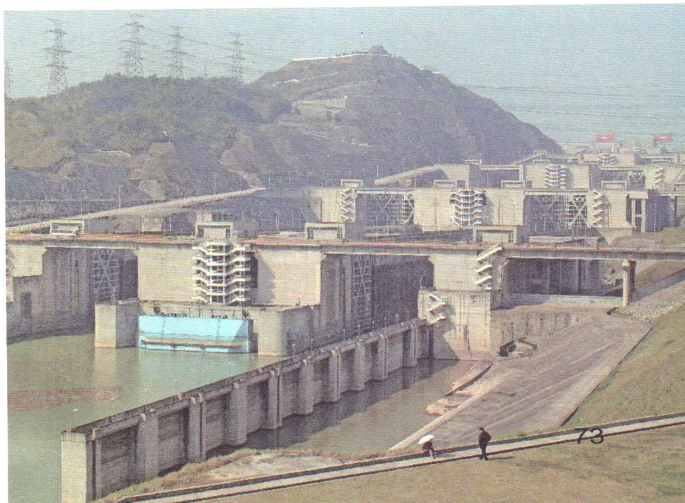
图8-21 五级方式的三峡船闸
