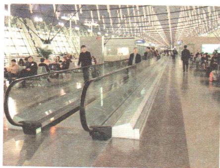
图7-4 机场候机楼中的自动人行道
